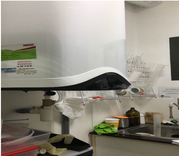
Nueva bomba de calor del establecimiento
