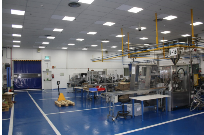
Planta y nuevas luminarias instaladas
